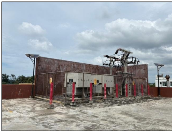
รูปที่ 3-23 หม้อแปลงไฟฟ้า และแผงกั้นที่ทำด้วยวัสดุทนไฟล้อมรอบหม้อแปลงไฟฟ้า
